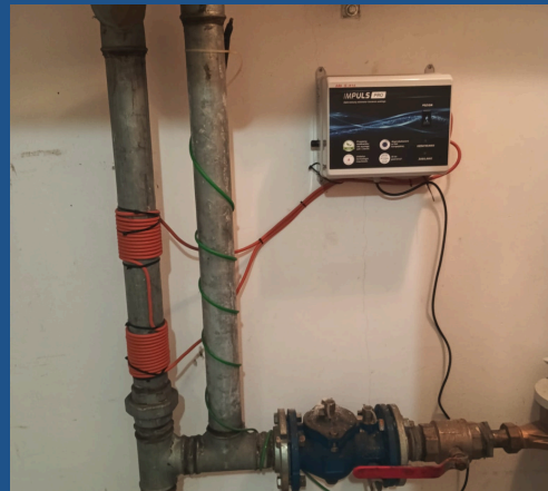
Instalacja na z.w.-montaż
